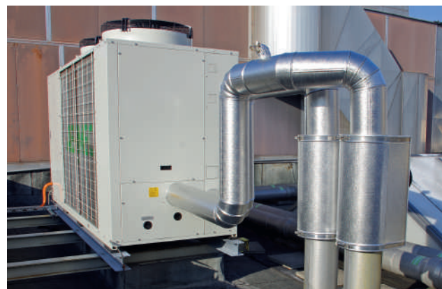
Für die Konditionierung des Lüftungssystems der Reinnräume wurde ein Kühlgerät auf dem Dach durch eine neue, effizientere Einheit ersetzt.
